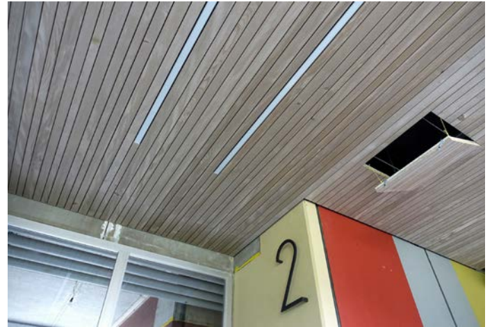
Am Ende der Passerelle im Gebäude C wurde eine Mockup-Situation eingerichtet. Die Holzdecke mit den integrierten Leuchtkörpern überzeugt.
