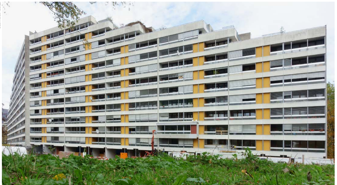
Die Westfassaden der beiden Telli-Gebäude werden komplett erneuert. Eine Musterwohnung im zweiten Obergeschoss (Balkon mit dem roten Paneel) zeigt, dass die neuen Balkone rund einen Meter weiter vorkragen.
