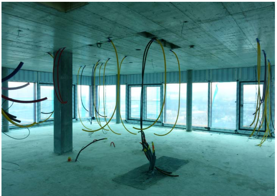
Das 23. Geschoss wartet noch darauf, in Wohnungen unterteilt zu werden.
