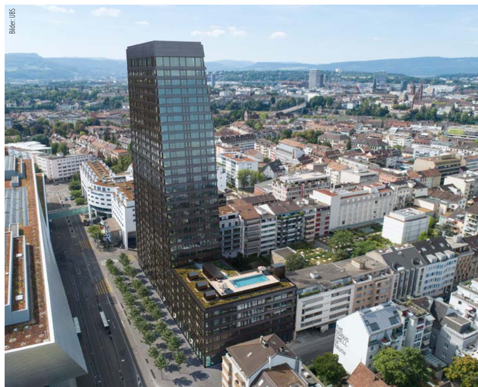
Auf dem Dach des Trakts an der Drahtzugstrasse steht den Mieterinnen und Mietern ein Pool mit einer Liegefläche zur Verfügung.
