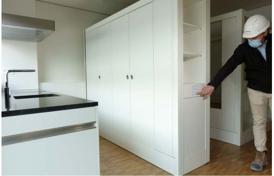
In den «MOVEment»-Wohneinheiten lassen sich hinter der fest installierten Küche ein Schrank und das Bett auf Knopfdruck verschieben.
