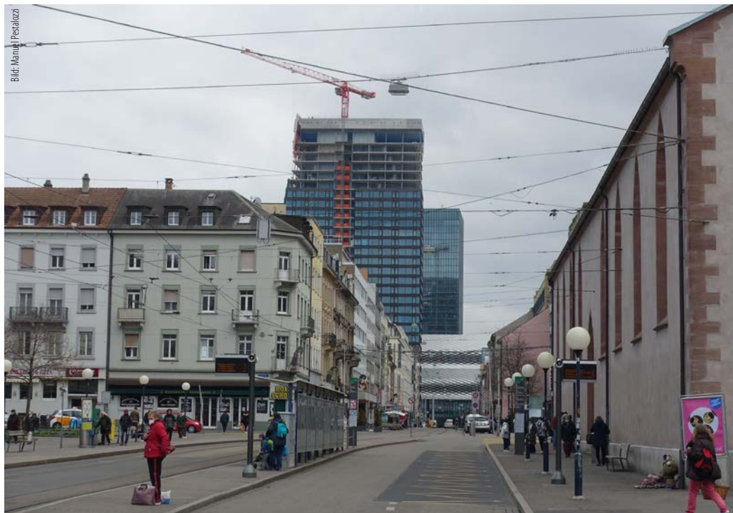
Vom Claraplatz her gesehen ergänzt der Claraturm die Bauten der Messe.
