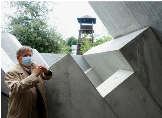
Architekt Quintus Miller wies beim Besichtigungsrundgang auf die hohe Qualität der Betonarbeiten hin.
