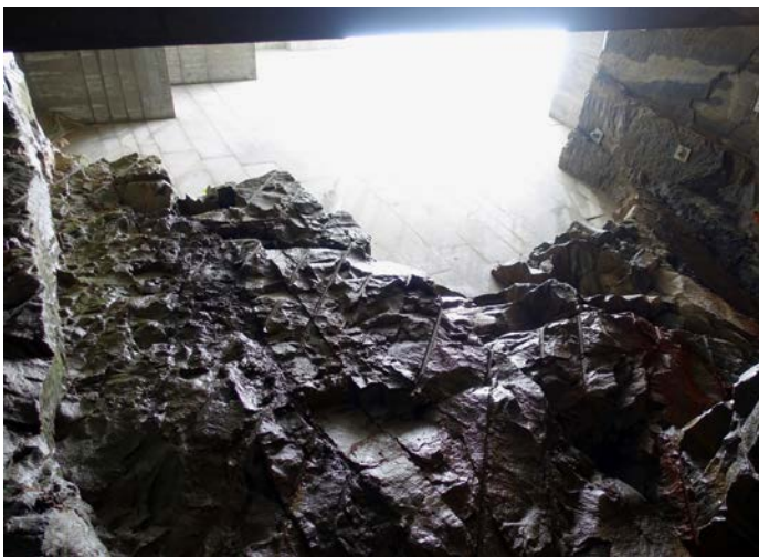
Im Lichtschacht des Treppenaufgangs treffen Beton und Gestein aufeinander. Die Ankerplatten machen den menschlichen Eingriff erkennbar.
