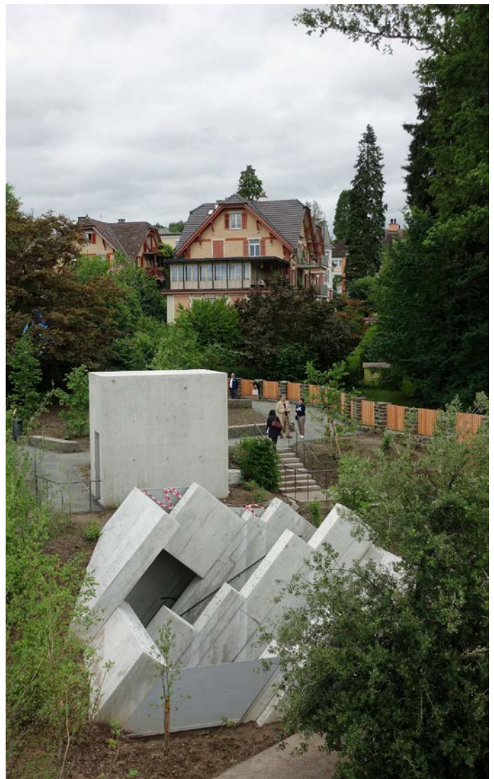
In der Sommerau stehen sich der Ausgang des Lifts und der fast kristallin wirkende Rand des Treppenaufgangs gegenüber.
