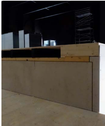
Der Orchestergraben lässt sich überdecken und als zusätzlicher Bühnenraum nutzen.
