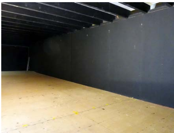
Die Überdeckung des Orchestergrabens liegt auf und kann deshalb schnell entfernt werden.
