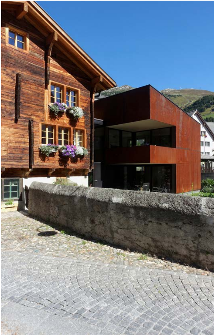
Strickbauweise aus dem 17. Jahrhundert neben einer korrodierten Stahlfassade aus dem 21. Jahrhundert – die steinerne Gartenmauer hilft, diese Gegensätze zu vereinen.
