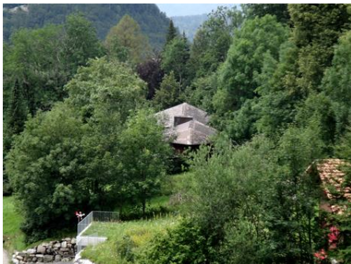
03M_Pestalozzi_Hasliberg (4608x3456 Pixel) Haus Alexander, Dachaufsicht
