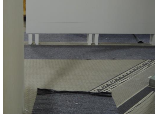
02_M_Pestalozzi_AusstellungsBaustelle (4609x3456 Pixel)
