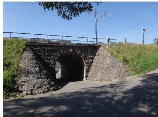
02_MPestalozzi_Hauensteintunnel Unterführung Brüelmattstrasse, Trimbach (3000x2250 Pixel)
