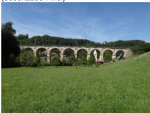
02_MPestalozzi_Hauensteintunnel Rümlinger Viadukt (3000x2250 Pixel)
