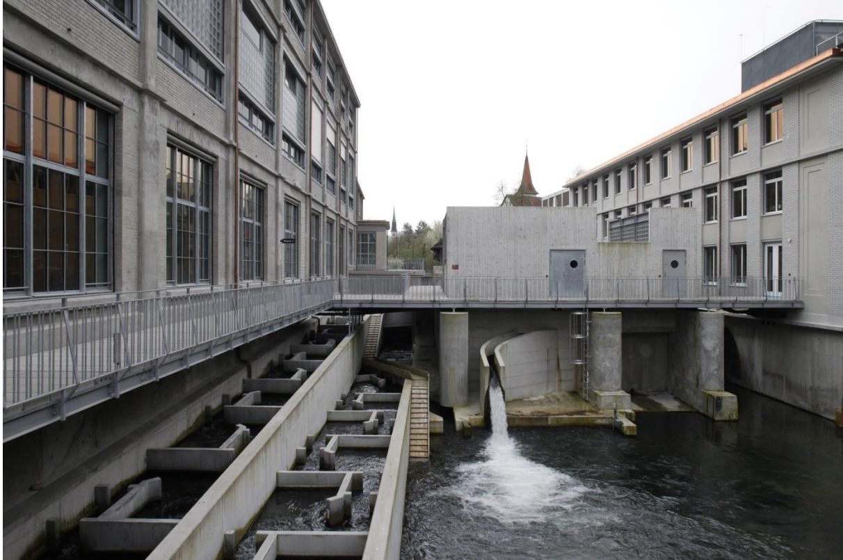
03_MPestalozzi_ZugimFruehling – Eine Fisch- und Bibertreppe macht im Bereich der Paperi Cham die Wanderung den Fluss Lorze aufwärts, vorbei am modernisierten Kraftwerk, für die genannte Fauna möglich.
