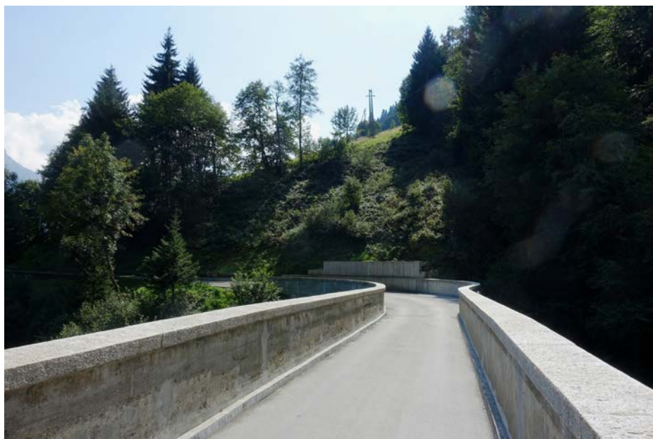
Bei der südlichen Zufahrt der Schrähabbrücke wurde eine kleine Ausweichstelle geschaffen.
