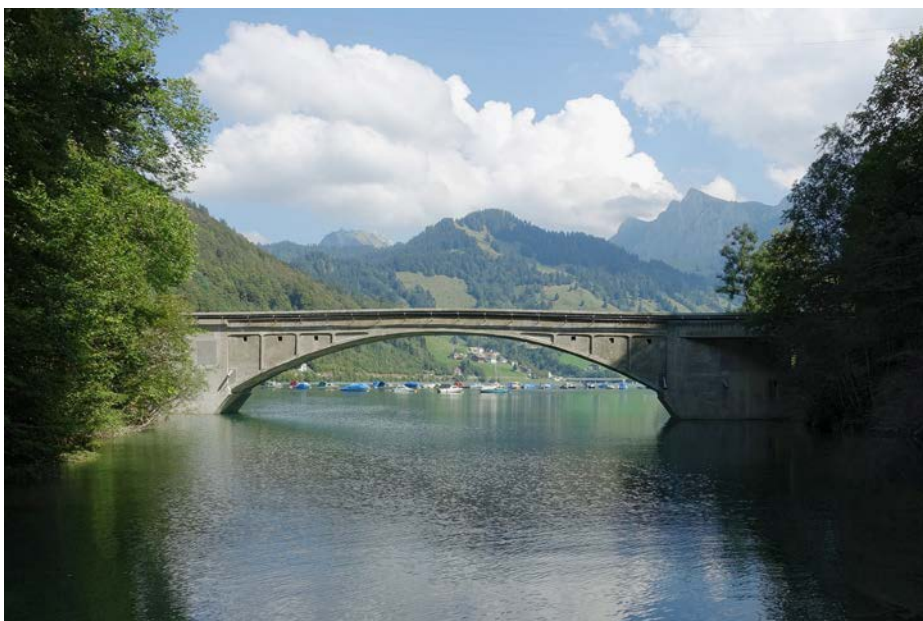
Die sanierte Schröblichbrücke überquert einen Seitenarm des Stausees.
