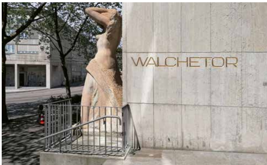
Nach fast 90 Jahren erkannte man das Sicherheitsrisiko bei dieser Kunst am Bau in Zürich. Ein robustes Geländer mit Handlauf vermindert es jetzt. BILD: MANUEL PESTALOZZI
